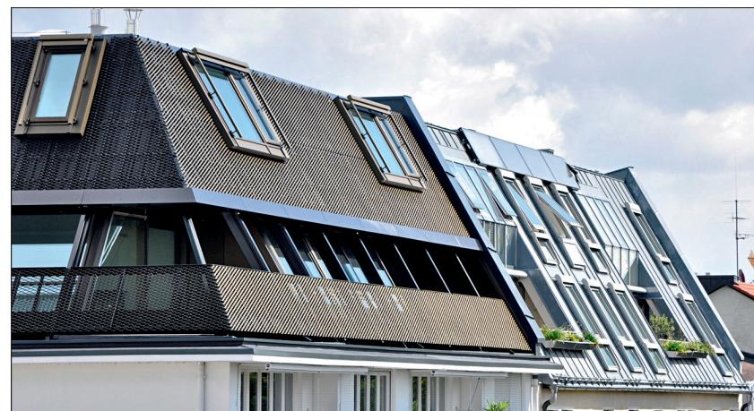
Der Dachaufstockung eines Bestandsgebäudes in Münchens Maxvorstadt sieht man den Holzbau darunter nicht an. Die engen Platzverhältnisse legten die Entscheidung nahe, mit vorgefertigten Elementen zu bauen.
