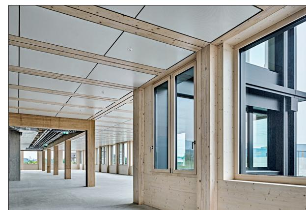
Der Skelettbau des „S22“ ist auch im Innern noch erkennbar. Die HBV-Decken sind Rippendecken mit Aufbeton. Zwischen den Rippen lassen sich Leitungen versteckt einbauen.
