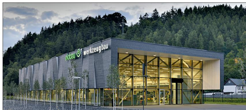
Lichtdurchflutete Produktionshalle der Fa. Ellobau in Probstzella: Ein filigranes Tragwerk aus „Baubuche“-Fachwerkträgern und -Stützen ermöglichte die elegante Konstruktion.
